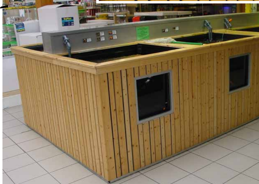
Abb. Verkleidung mit lasierten Fichteleisten und Schattenfugen
